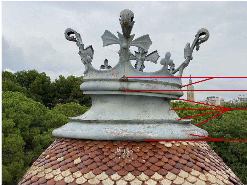
DEFORMACIÓN DE LA CORONA Y PÉRDIDA DE LA HORIZONTALIDAD
