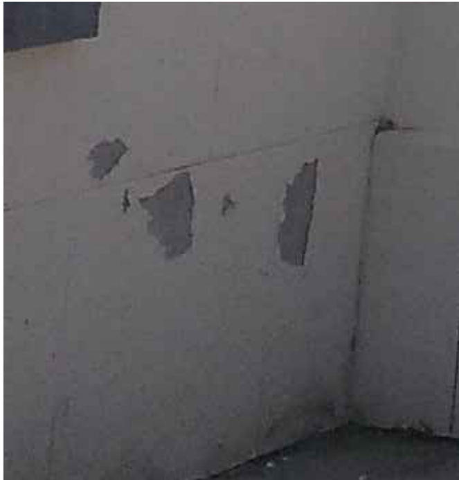
DESCONCHAMIENTOS DE PINTURA DEL BASAMENTO DE PIEDRA
