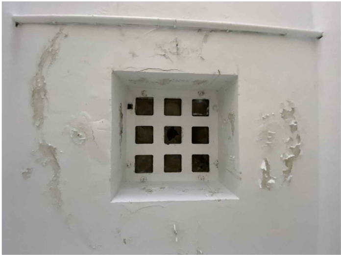
TRAGALUZ CON GRIETAS PERIMETRALES EN EL SOPORTE Y PIEZAS DE VIDRIO ROTAS
