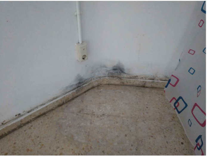
HUMEDADES EN MUROS Y SUELOS
