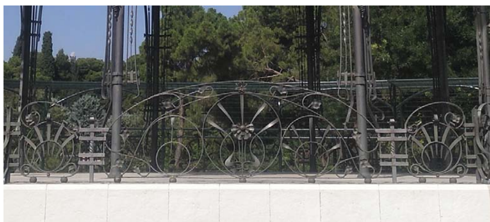
Barandilla actual, con el cuerpo central original (con lagunas), y los dos módulos añadidos en la ampliación del basamento
