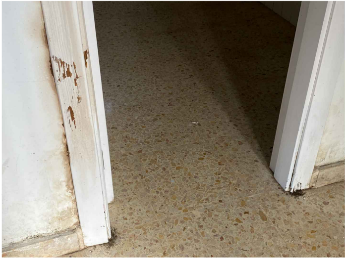
CARPINTERÍAS INTERIORES DEGRADADAS POR LA HUMEDAD
