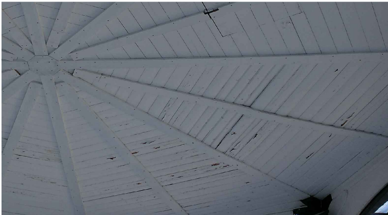
TABLILLAS RADIALES AÑADIDAS EN 2022 COMO REPARACIÓN PUNTUAL
