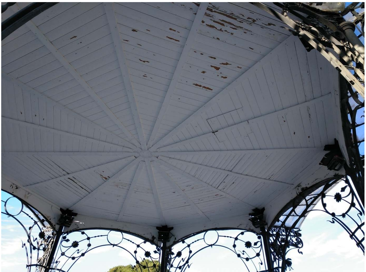
15. Entablado del techo
