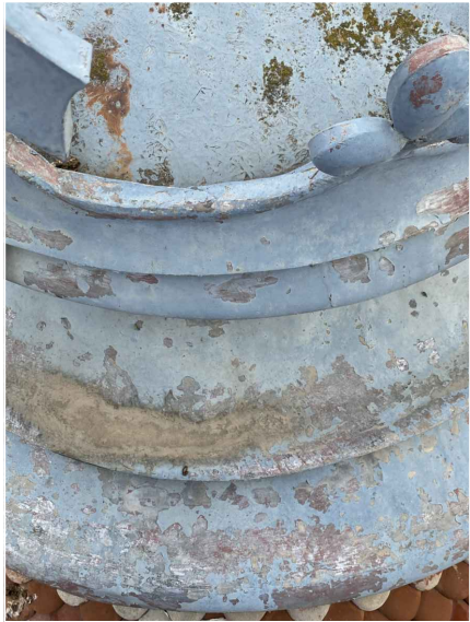
DEFORMACIÓN DE LA CORONA Y PÉRDIDA DE LA HORIZONTALIDAD
