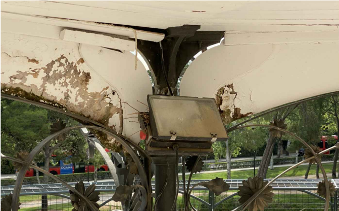
TABLILLAS RADIALES AÑADIDAS EN 2022 COMO REPARACIÓN PUNTUAL
